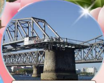
สะพานขาดตานตง
